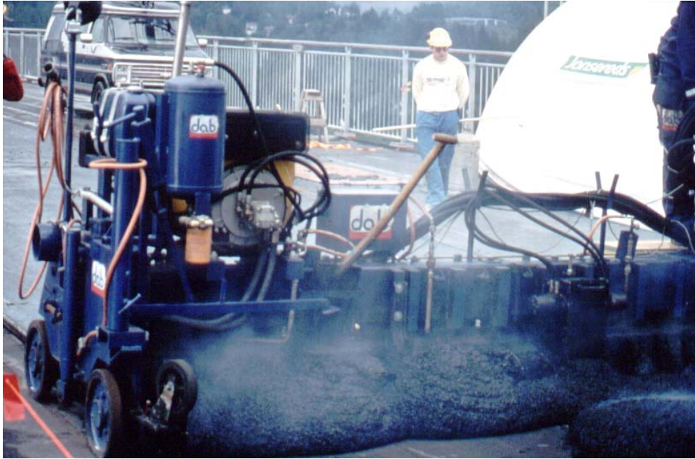
Figur 3.4 Utläggning av gjutasfalt på bro. Foto: Domiflex AB.
