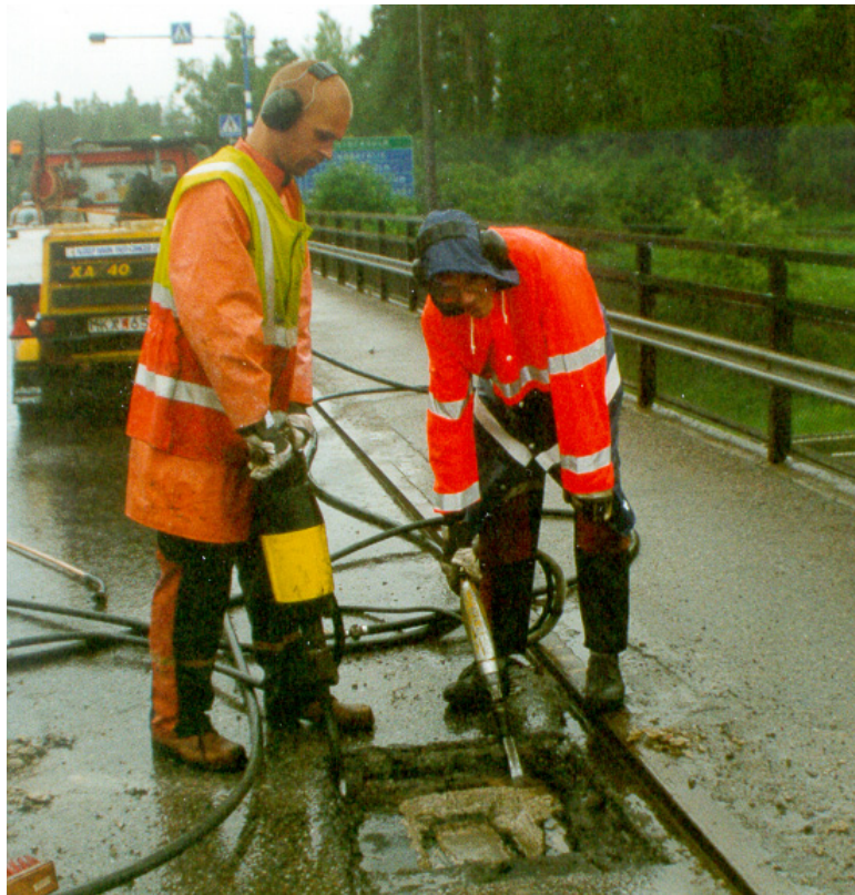
Figur 3.11 Fönsterupptagning på bro i Stockholm.
