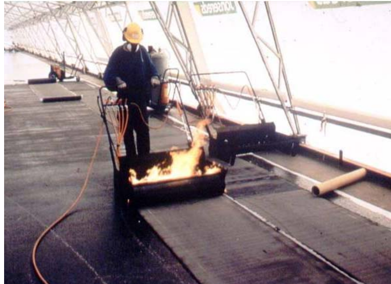
Figur 3.8 Polymermodifierad tätskiktsmatta svetsappliceras på betongbro.
