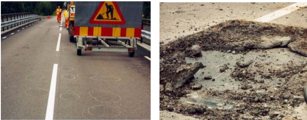
Figur 3.5 Blåsbildning på betongbro. a) Blåsor har markerats. b) Reparationsarbetet har inletts, Edwards och Westergren (1999).
