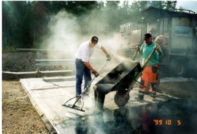
Figur 3.9 Asfaltmastix läggs ut på betongbro.
