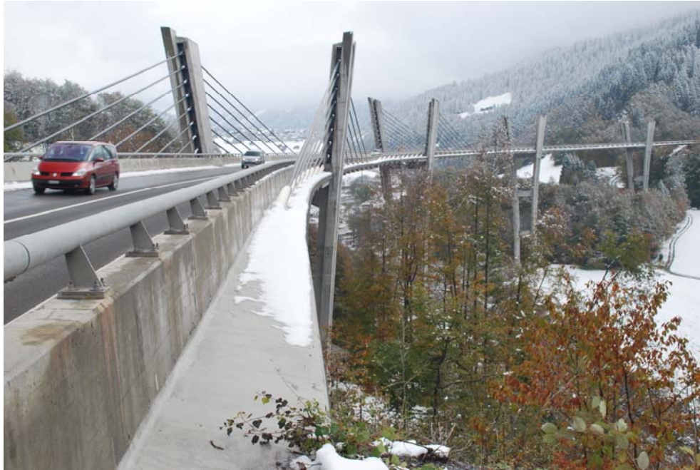
Figur 2.27 Sunnibergbrücke i Schweiz.
