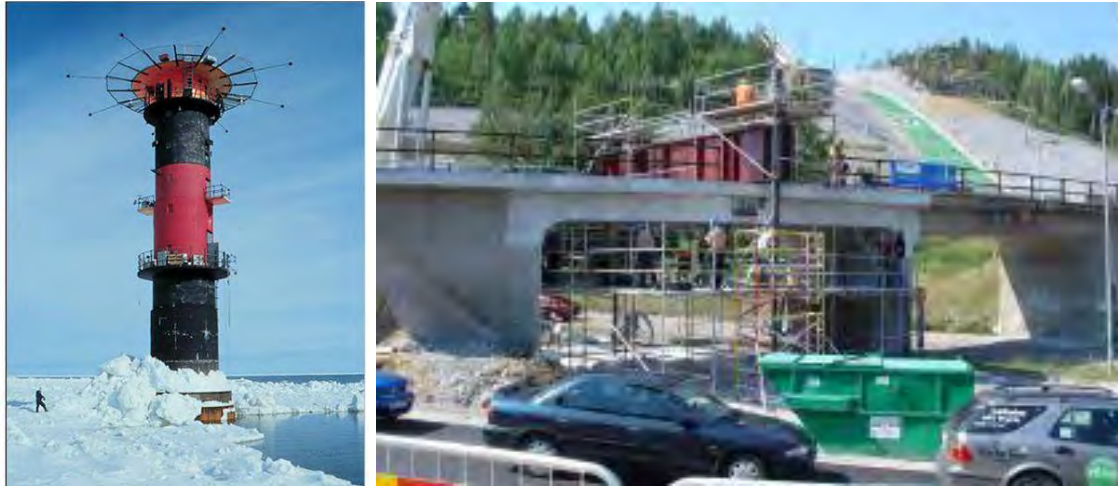
Figur 6. Bilden till vänster visar fyren Nordströmsgrund och bilden till höger brottbelastningsprovning av en järnvägsbro i Örnsköldsvik.
