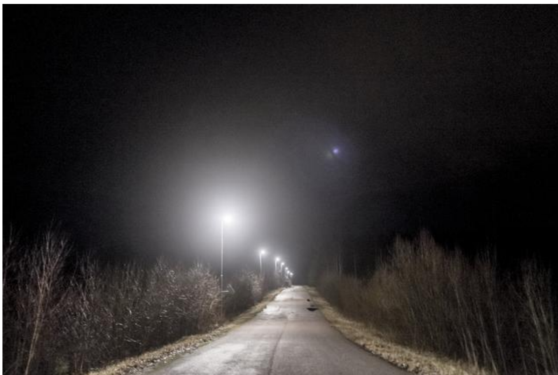
Figur 6. Bild väg med icke ändamålsenlig belysning
