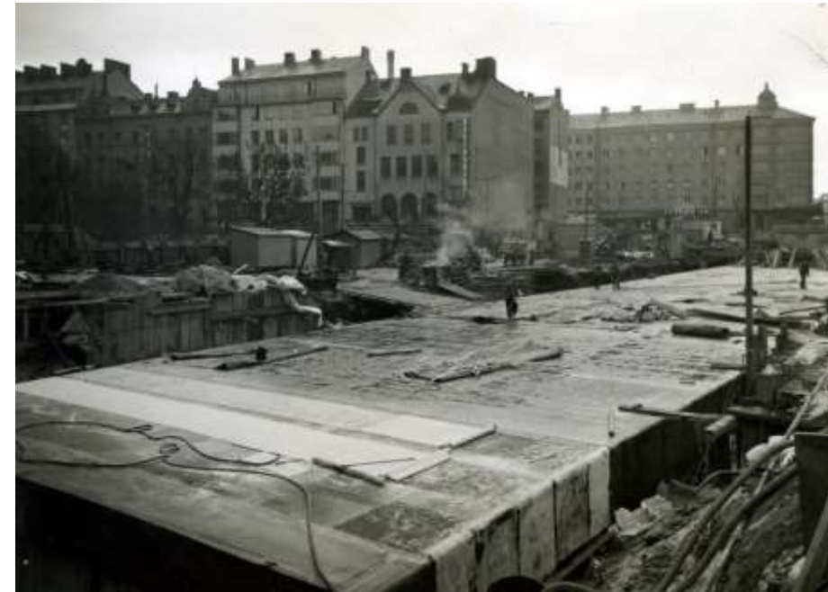
Tätskiktsmontage vid byggnation av tunnel
