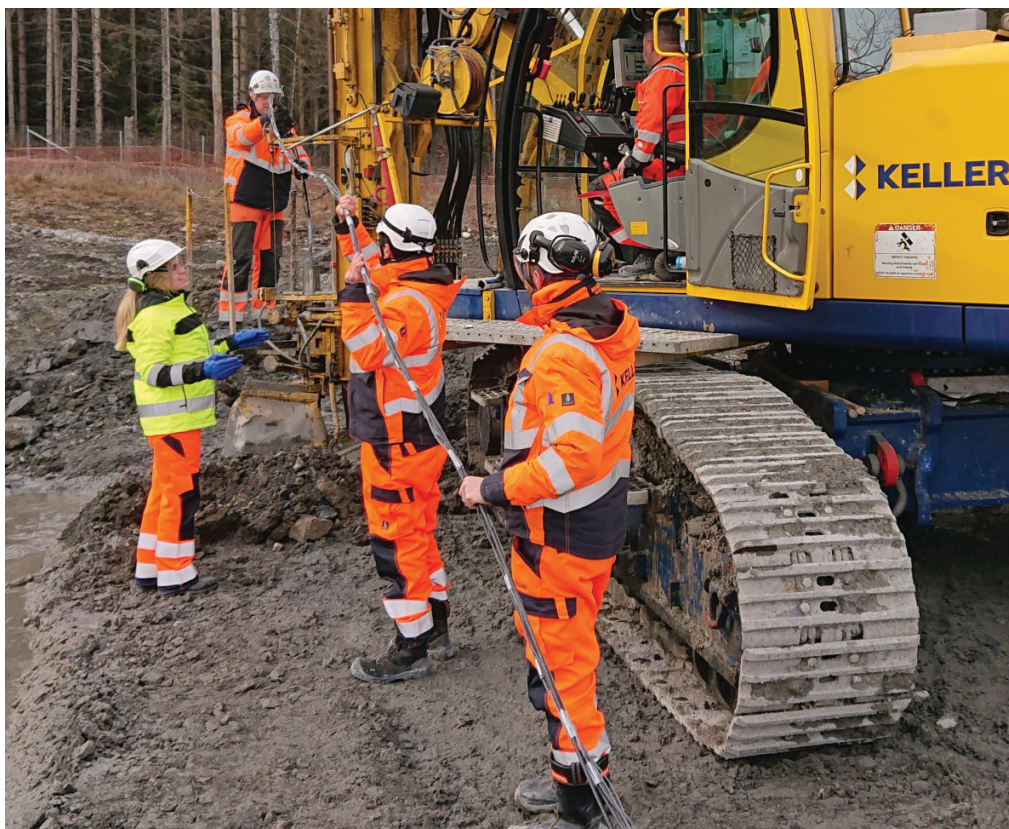
Figur 1. Fältförsök med installation av elektroder och temperaturgivare i jetpelare i Moss.
