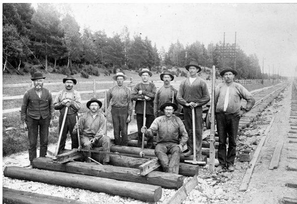
Arbete på Ostkustbanan , dubbelspår mellan Stockholm och Uppsala vid Alsike. Ca 1900. Bildkälla: Wikipedia
